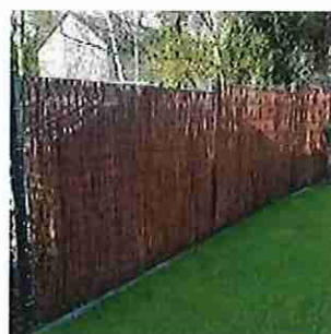
Canisses sur grillage à moutons
