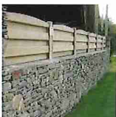
Muret pierres réhaussé bardage bois
