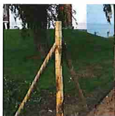
Grillage «à moutons» sur poteaux châtaigniers
