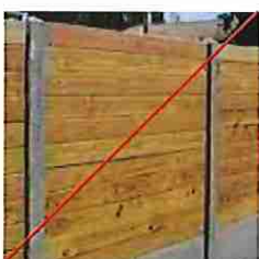
Lames bois sur soubassements maçonnés
