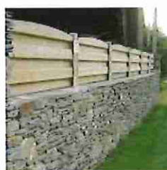
Muret pierres réhaussé bardage bois
