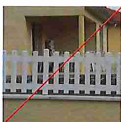
Muret maçonné réhaussé de bardage PVC
