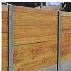
Lames bois sur soubassements maçonnés
