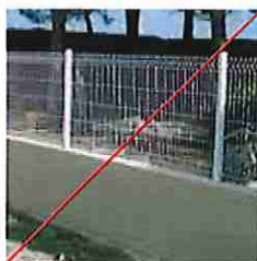
Muret maçonné réhaussé grille souple
