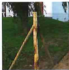
Grillage «à moutons» sur poteaux châtaigniers
