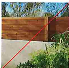
Muret maçonné enduit réhaussé bardage bois
