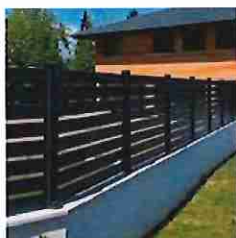
Muret maçonné réhaussé bardage alu à claire_voie
