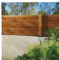
Muret maçonné enduit réhaussé bardage bois
