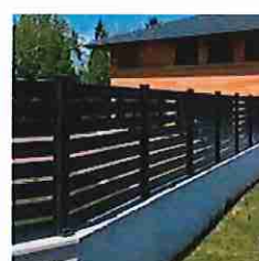
Muret maçonné réhaussé bardage alu à claire_voie
