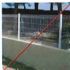
Muret maçonné réhaussé grille souple
