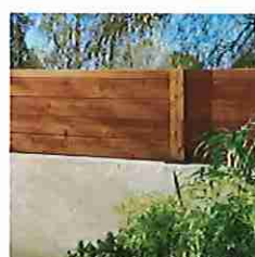
Muret maçonné enduit réhaussé bardage bois
