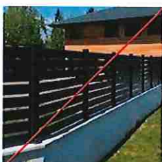
Muret maçonné réhaussé bardage alu à claire_voie
