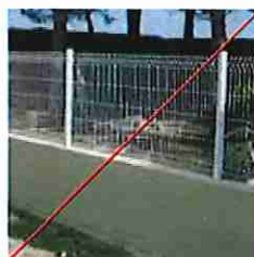
Muret maçonné réhaussé grille souple
