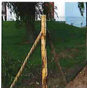
Grillage «à moutons» sur poteaux châtaigniers
