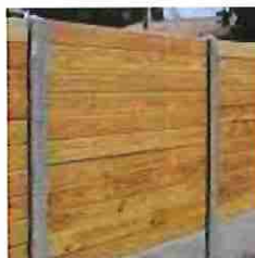
Lames bois sur soubassements maçonnés
